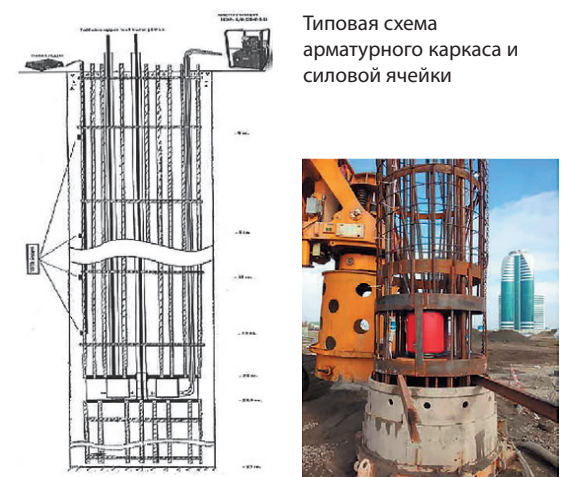
Арматурный каркас испытываемой сваи
